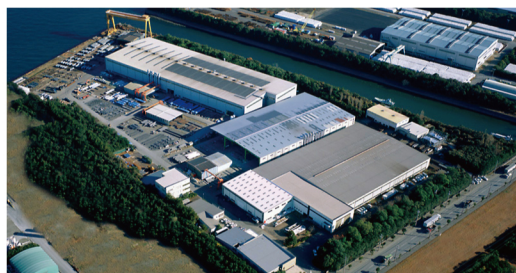
yess建築の部材を一貫生産する専用の工場 (横河システム建築 千葉工場)
